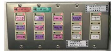
▲照明のスイッチは表示で明確になっています
